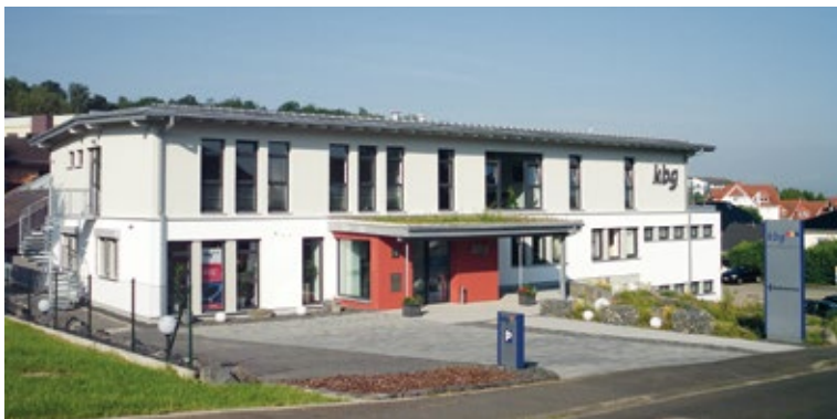
Energieeffizientes Kundenzentrum: Die KBG Kraftstrom-Bezugsgenossenschaft Homberg eG hat ihr aus dem Jahr 1980 stammendes Verwaltungsgebäude 2011 umfangreich energetisch sanieren lassen. Wärmeverluste über die Gebäudehülle werden konsequent vermieden. Die erzielte Energieeinsparung beträgt mehr als 50 Prozent.
